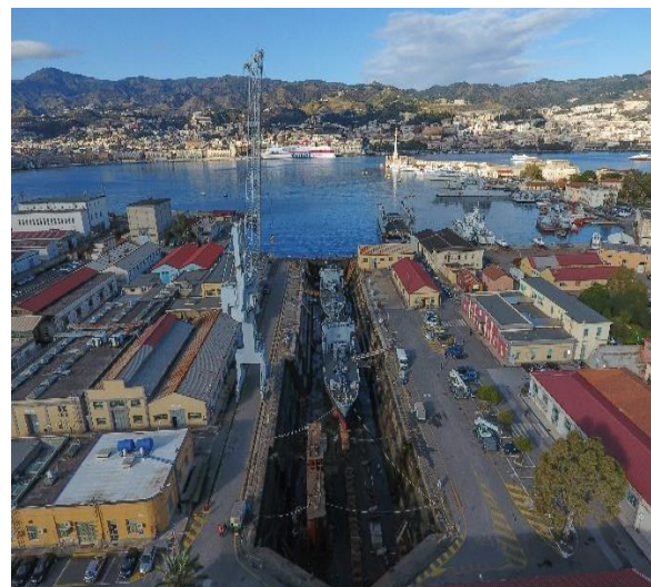
Bacino di carenaggio in muratura
